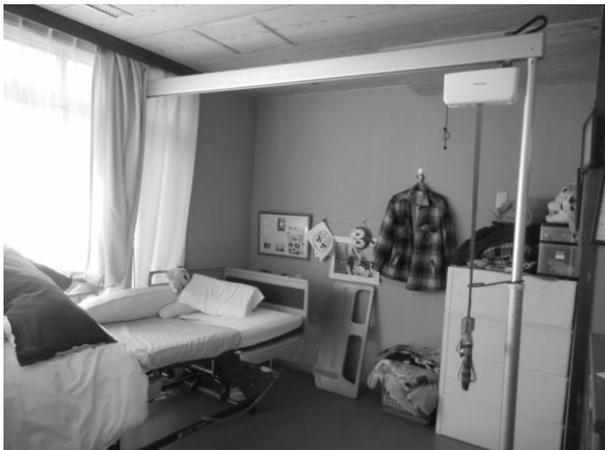
写真①が、生活 1 課に導入された設置式介護リフトである。特に改修工事等は不要で、居室に設置できる。ベッドから車椅子やポータブルトイレへの移乗に使用しており、コードレスリモコンで簡単に上げ下げが出来る。水平移動は手動で、軽く
